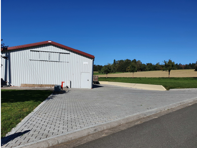
Abb. 4: Blick Rchgt. Nord-West auf angrenzendes Bestandgebäude und Grünlandfläche mit 3 Obstbäumen
