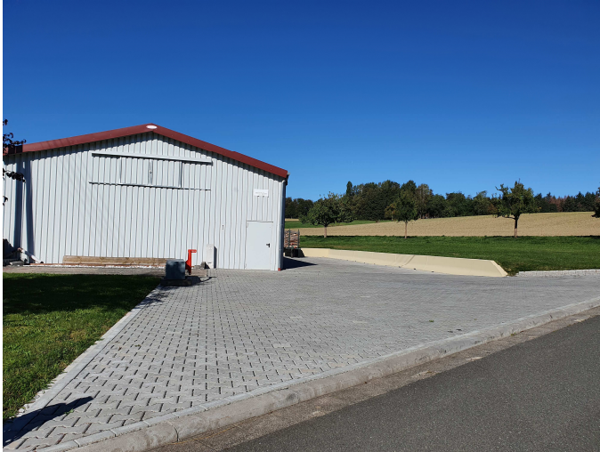
Abb. 4: Blick Rcthg. Nord-West auf angrenzendes Bestandgebäude und Grünlandfläche mit 3 Obstbäumen
