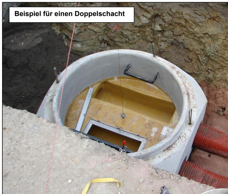
Die Tiefe ergibt sich aufgrund der weiteren Kanalführung zu  $t = 1,80$  m. Der Schmutzwasserkanal erhält eine Dimension von DN 250 PP.
