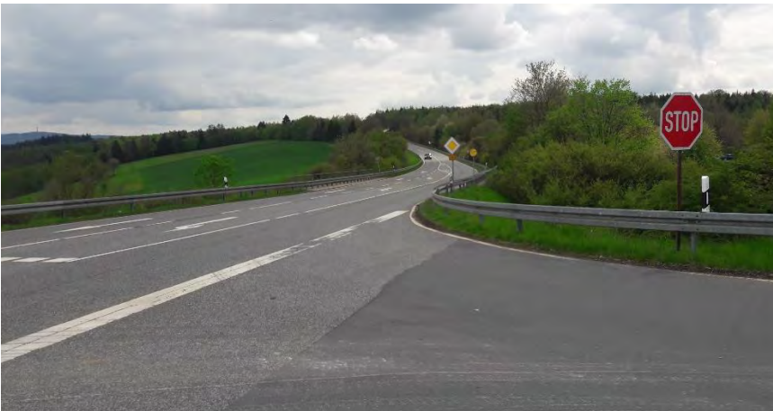
Abbildung 2.2: Fotodokumentation – Anschluss Bäderstraße/B 260 (Blick Richtung Süden)
