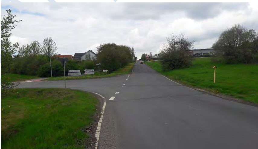
Abbildung 2.3: Fotodokumentation – Anschluss Am Windpark/Bäderstraße (Blick Richtung Norden)
