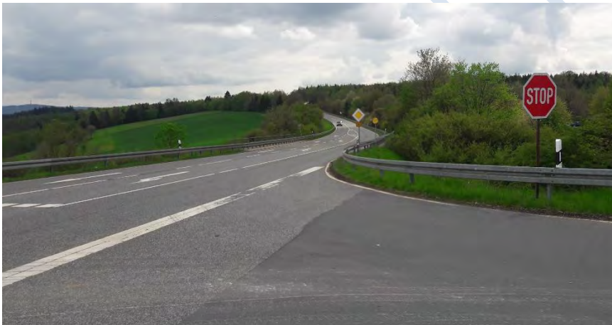
Abbildung 2.2: Fotodokumentation – Anschluss Bäderstraße/B 260 (Blick Richtung Süden)
