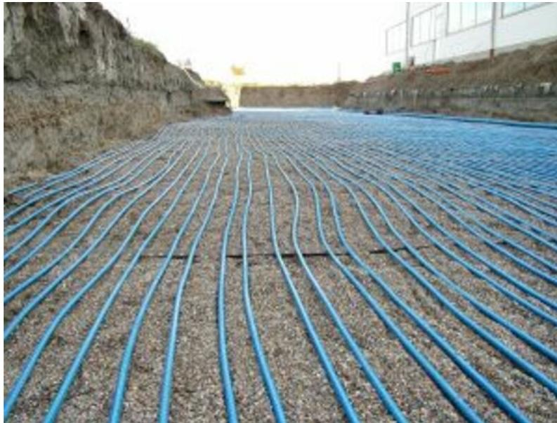
Erdwärme-Kollektoren (Quelle: Bundesverband Geothermie)
